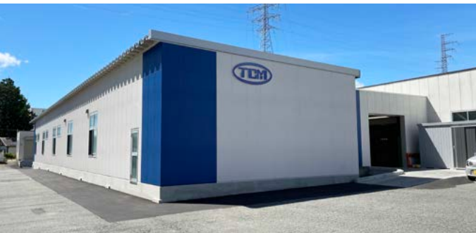
薬品との総合提案を支える、東京化工機の製造拠点
