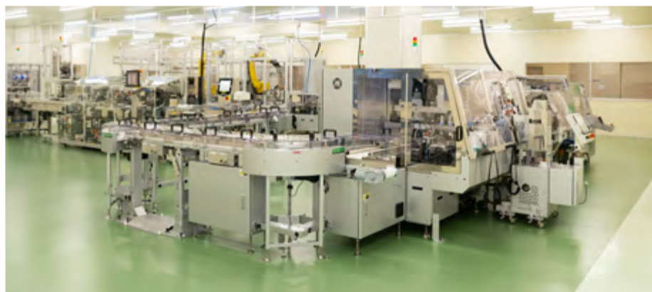
岩城製薬佐倉工場 固形剤製造設備
